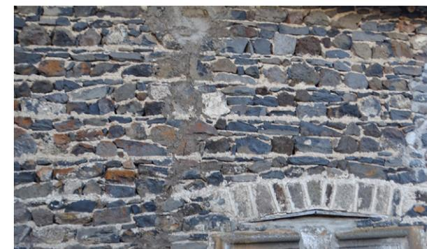
Appareillage de moellons de pierres d'origine volcanique
