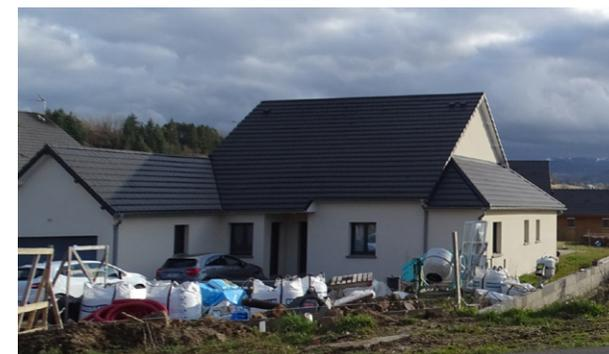
pavillon en construction – complexité de la volumétrie générant une complexité de la toiture au regard des celles des bâtiments traditionnels (noue, croupe partielle...)
