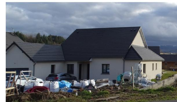
Pavillon en construction – complexité de la volumétrie générant une complexité de la toiture au regard des celles des bâtiments traditionnels (noe, croupe partielle...)
