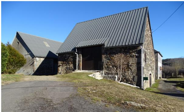
Grange-étable à Farges : l'accès de l'étable est sur le mur pignon en partie basse, celui de la grange en partie haute, via une montade réduite du fait de l'adaptation du bâtiment à la pente ; proportion importante de la toiture sur la façade ; adaptation de la toiture à la hauteur de l'accès à la grange.
