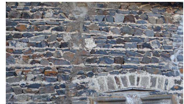
Appareillage de moellons de pierres d'origine volcanique
