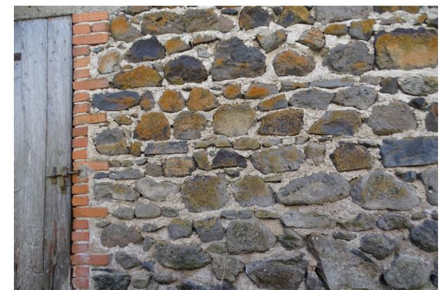
Appareillage de moellons de pierres d'origine volcanique et encadrement en brique
