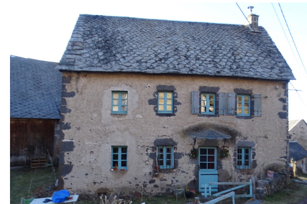
Façade enduite laissant apparaître les chaînages d'angles et encadrements des ouvertures en pierre de taille, couverture en lauze, à Vareilles
