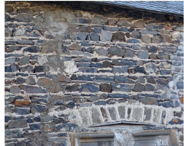
Détail constructif : Construction en pierre d'origine volcanique, trouvée sur place ; et couverture en ardoise d'origine probablement corrézienne.
