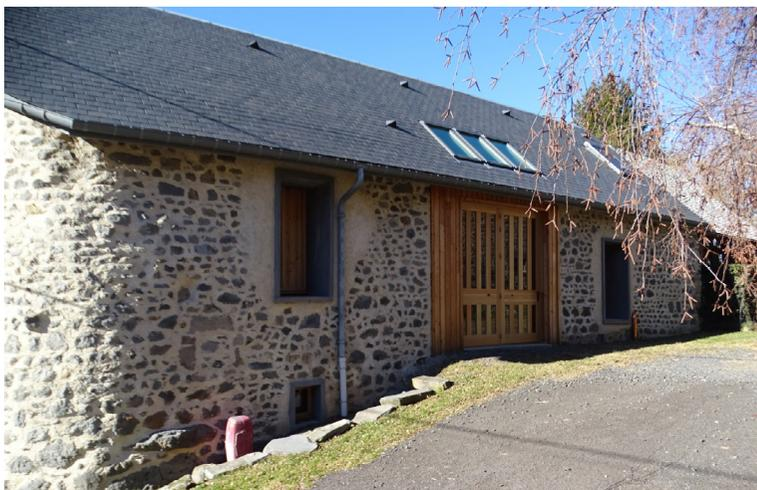
A Polagnat : réfection de la toiture en petite ardoise rectangulaire, traitement soignée des nouvelles ouvertures en façade fenêtre de toit bien agencées, joint beige entre les pierre...
