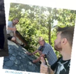
28/06/2025 - Dernier jour de toiture
